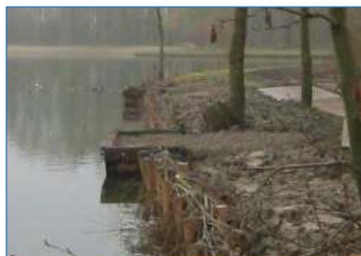
Foto: Halfverharding; Toepasbaarheid: bij alle voorkomende viswateren
