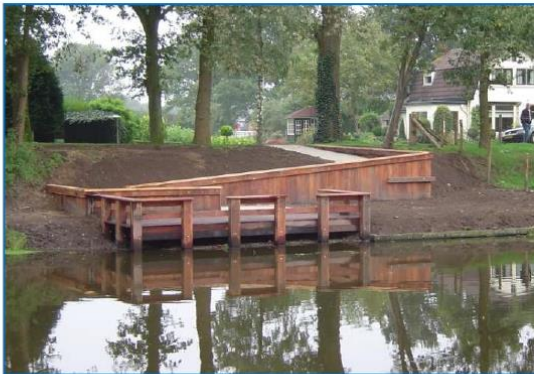
Foto: mindervalide steiger met dubbele helling
