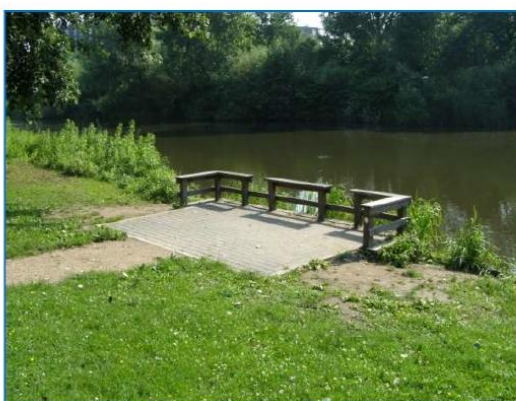
Foto: Elementen-verharding; Toepasbaarheid: bij alle voorkomende viswateren
