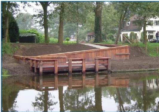
Foto: mindervalide steiger met dubbele helling
