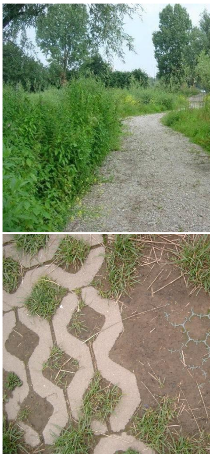
Figuur 5.3 Voorbeelden van halfverharding in toegangspaden
